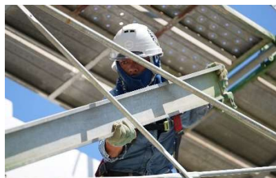
足場解体作業の様子
